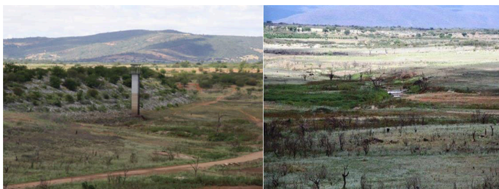
Figura 17-Barragem do Rio do Paulo- Rio de Contas-BA
