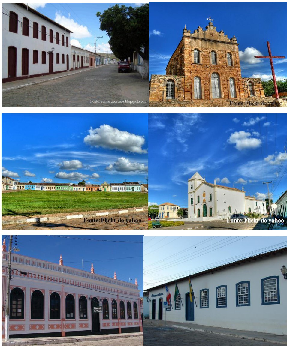
Figura 11 - Construções típicas da cidade de Rio de Contas no período da mineração
